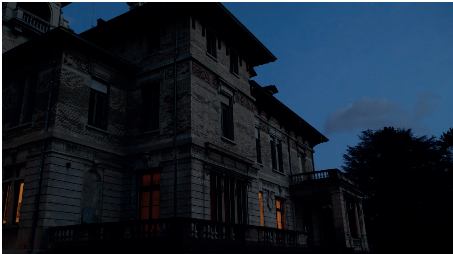
Vue de la Villa Gillet à Lyon, durant la résidence de création de Listen to the house , février 2021.
